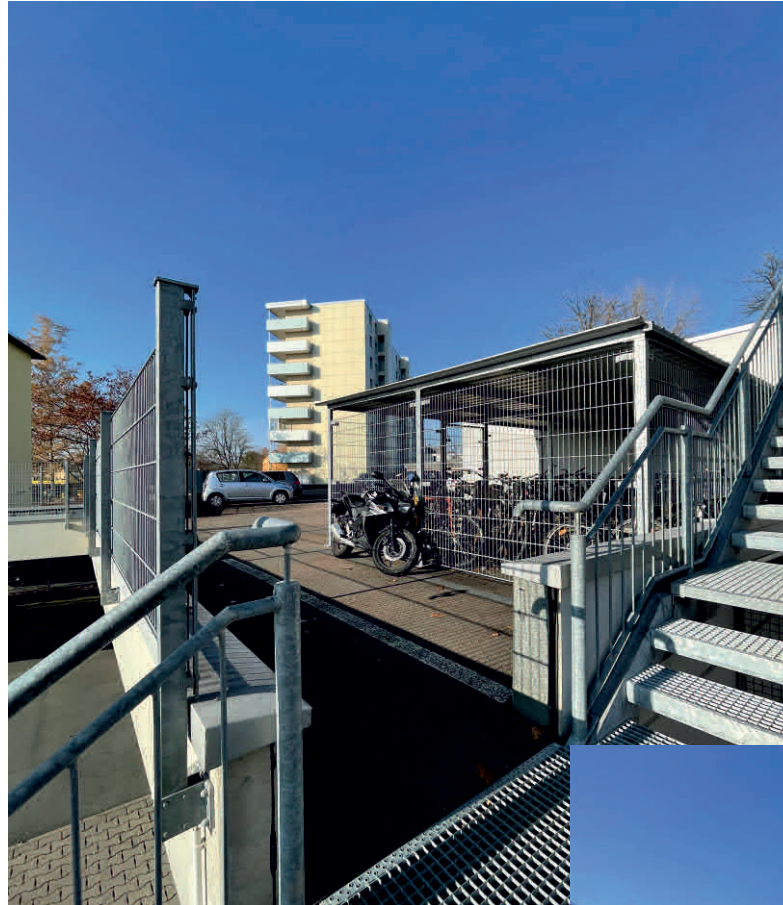
Überdachtes, absperrbares Fahrradhäuschen
